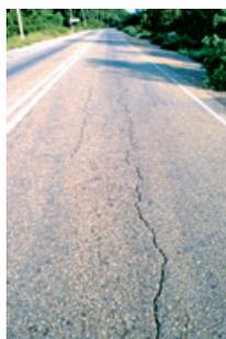
(b) Trincas longitudinais longas (TLL)
