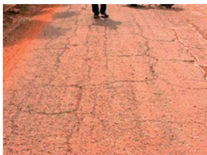
(e) Trincas de bloco com erosão (TBE)
