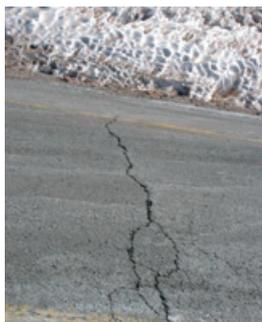
(j) Trinca de retração térmica
