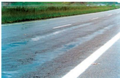
(a) Afundamento por consolidação em trilha de roda (ATC)
