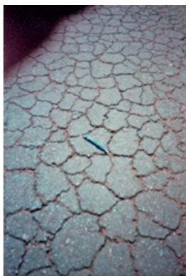
(h) Trincas tipo couro de jacaré de jacaré (J)
