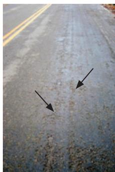
(c) Falha de bico espargidor
