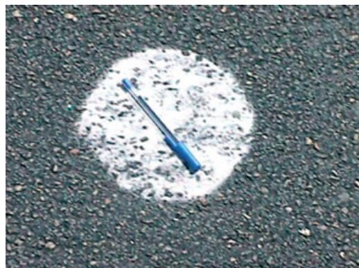
(b) Microrrevestimento asfáltico a frio com macrotextura aberta
