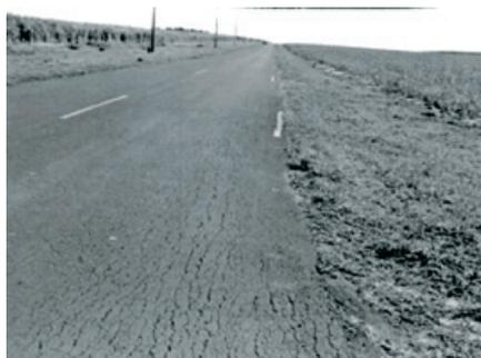
(i) Conjunto de trincas longitudinais longas
