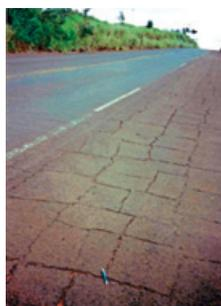
(f) Trincas de bloco sem erosão (TB)
