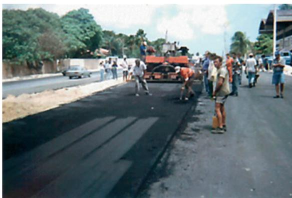
(b) Revestimento asfáltico sendo executado
