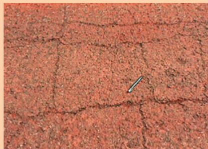
(f) Solo-cal: trincas devido à retração
