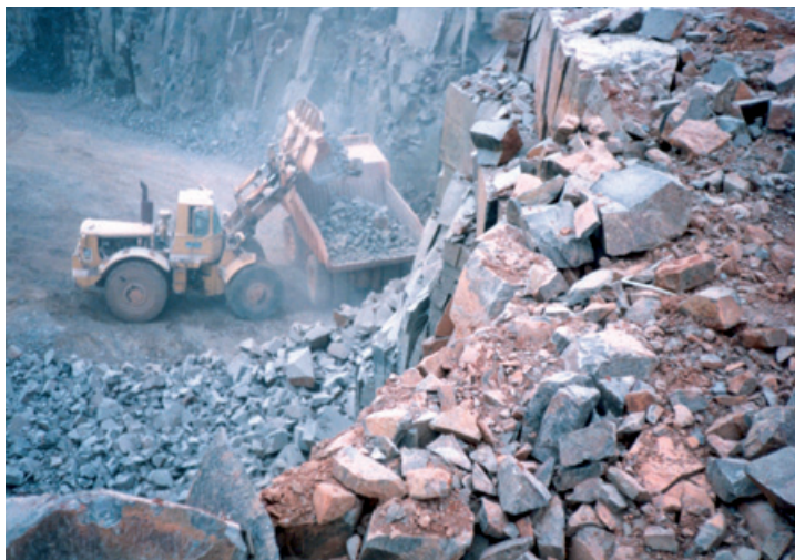
Figura 3.4 Carregamento de um caminhão na pedreira
