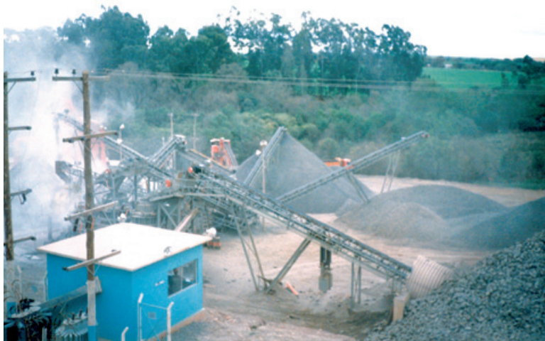
Figura 3.6 Vista geral de uma instalação de britagem
