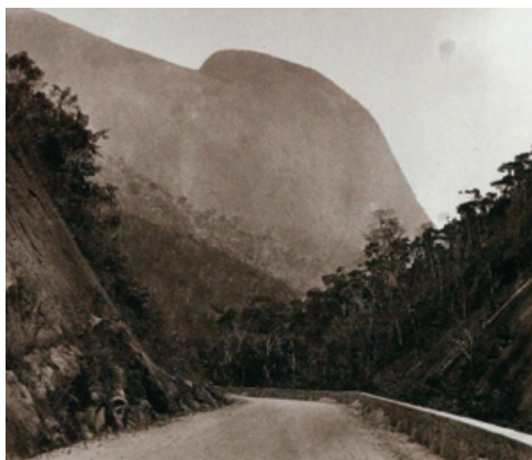
Figura 1.6 Estrada União e Indústria – foto à época de sua construção (Concer, 1997)
