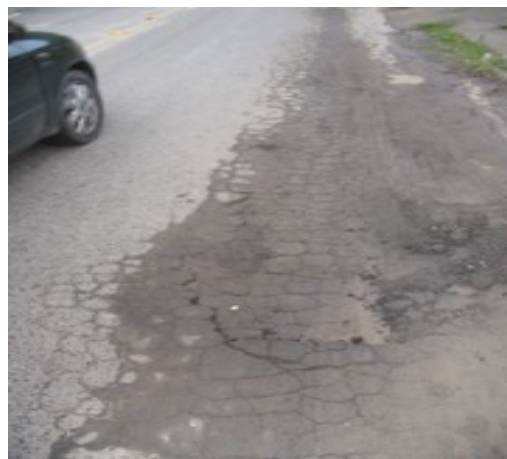
Figura 5. Obra concluída há dez meses.
