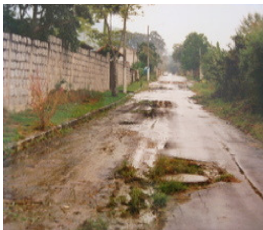
Figura 8. Obra concluída há dez meses.
