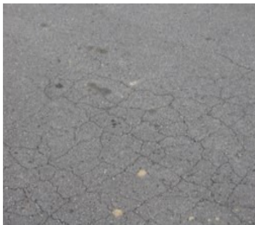
Figura 4. Obra concluída há 1 ano e três meses.
