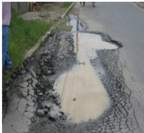
Figura 7. Obra concluída há 1 ano e três meses.
