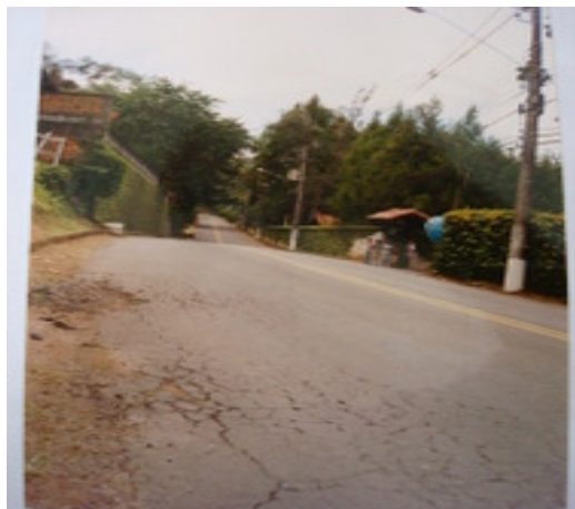
Figura 6. Obra concluída há 1 ano e três meses.
