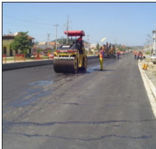
Figura 2. Compactação da camada de CBUQ com o rolo compressor.
