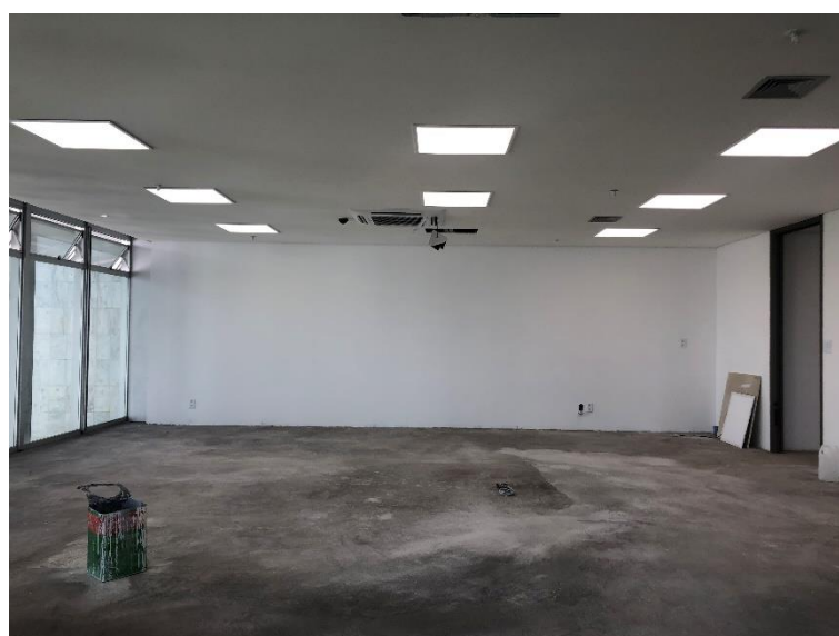
Figura 36 - Gabinete com iluminação em painéis de LED Fonte: Arquivo da autora
